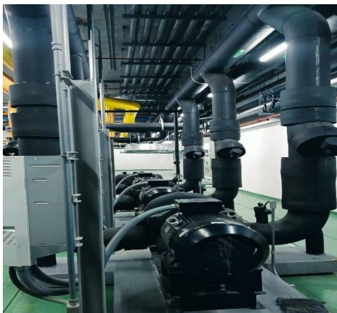
รูปที่ 25 ปั๊มน้ำเย็น (Chilled Water Pump) ชุดปฐมภูมิ และทุติยภูมิ
