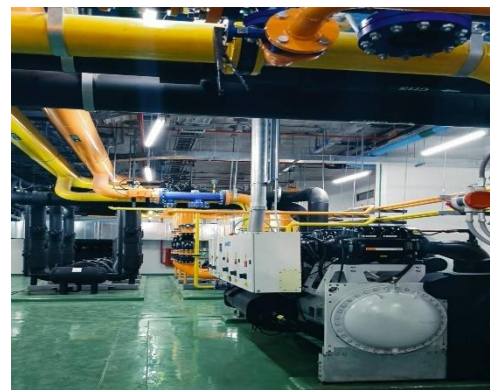
ระบบปรับอากาศ Water Cooled Chiller
