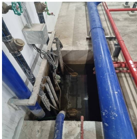
รูปที่ 41 ถังสำรองน้ำดับเพลิง
