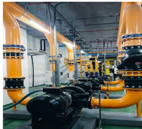
รูปที่ 25 ปั๊มน้ำเย็น (Chilled Water Pump) ชุดปฐมภูมิ และทุติยภูมิ
