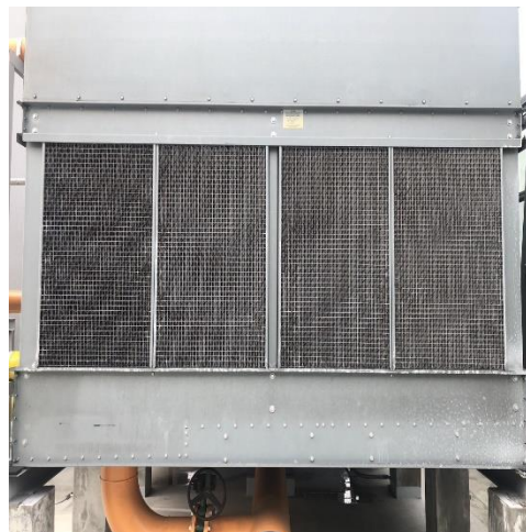
รูปที่ 48 อุปกรณ์ป้องกันการฟุ้งกระจายของละอองน้ำจากท่อฝังเย็น
